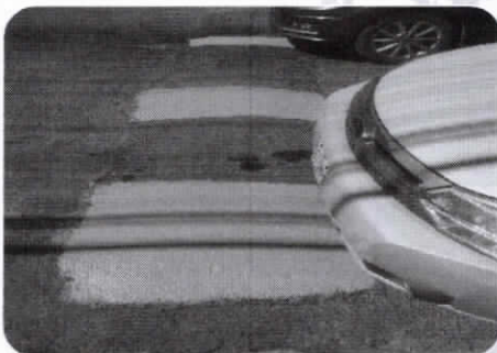
Calle Zaragoza entre Calle Joaquín Valle Rmz. y Calle Rosendo Garza, Zona Centro
