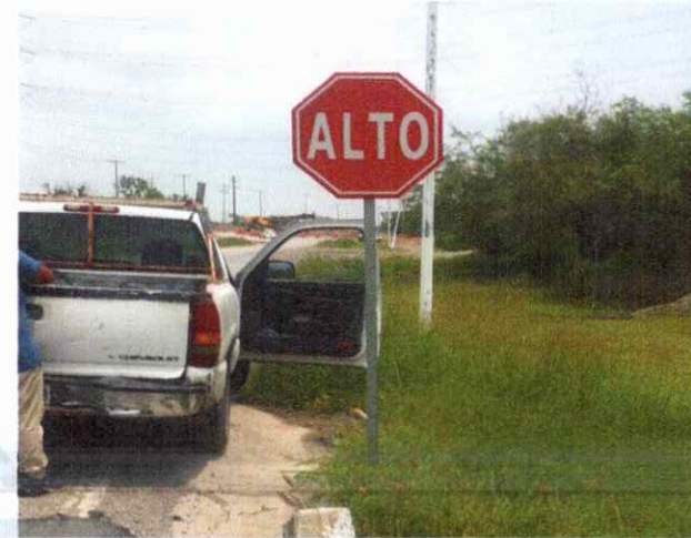
SE INSTALO LAMINA SEÑALAMIENTO DE ALTO CARR. CHIHUAHUITA Y LIBRAMIENTO OTE.
